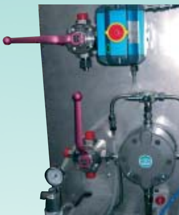
Installationen für Molcheingabe und Molchauslass zum Entleeren und Reinigen von Materialleitungen
